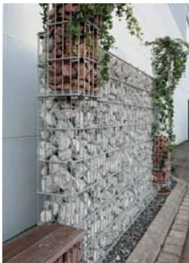
Gabionenwand erstellt mit Hilfe von Winkelclips, ohne Pfosten
